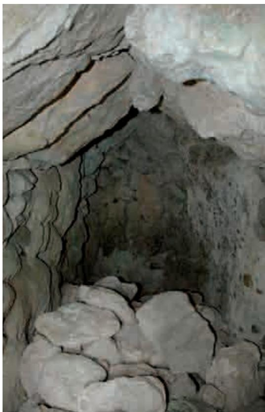
Figura 110. Cubierta a doble vertiente del *qanat* de Benicoraix.
