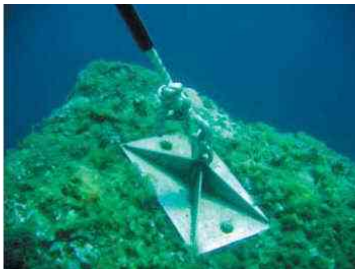
Figura 8.14. Anclaje por tacos químicos sobre lecho rocoso.
