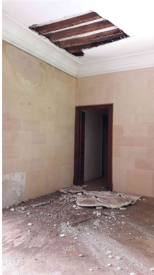
Detalle del cieloraso en la planta noble
