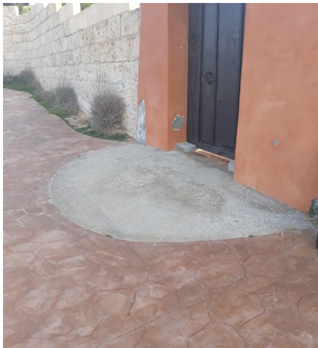
Paseo Marítimo Costa de la Calma
