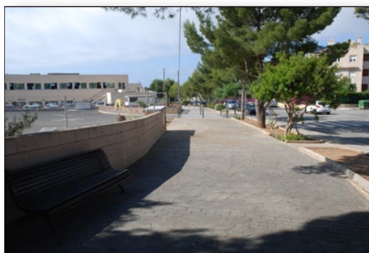
El torrente discurre bajo viario peatonal
