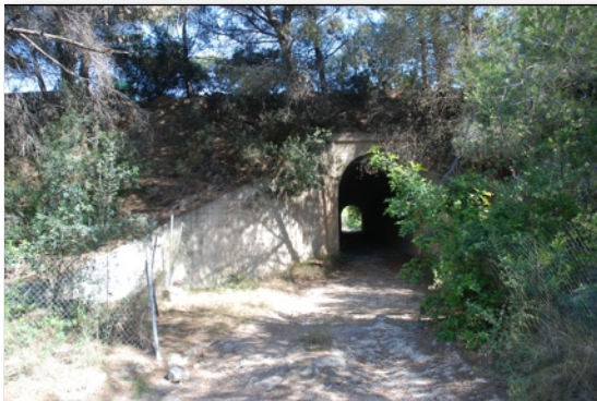
Obra de fábrica bajo la autopista (ámbito antiguo)
