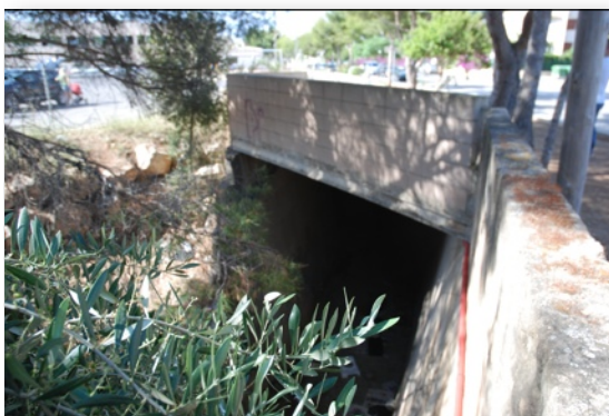
El torrente discurre soterrado en el límite del SGECC Son Caliu.
