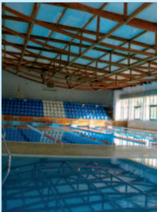
Nueva cubierta de la piscina de Calvià.
