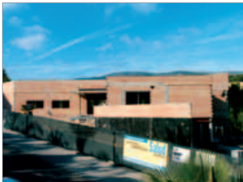
Últimas obras en el centro de Bendinat.
