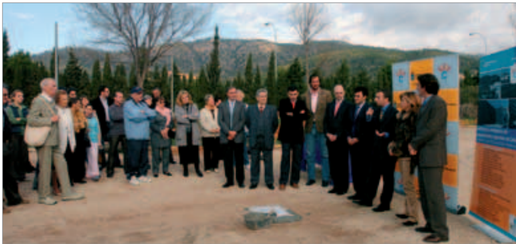
Numerosos vecinos acudieron a la puesta de la primera piedra de la futura zona deportiva.
