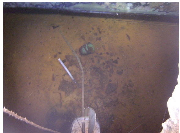
Descripción 281: Vista del interior del aljibe.
