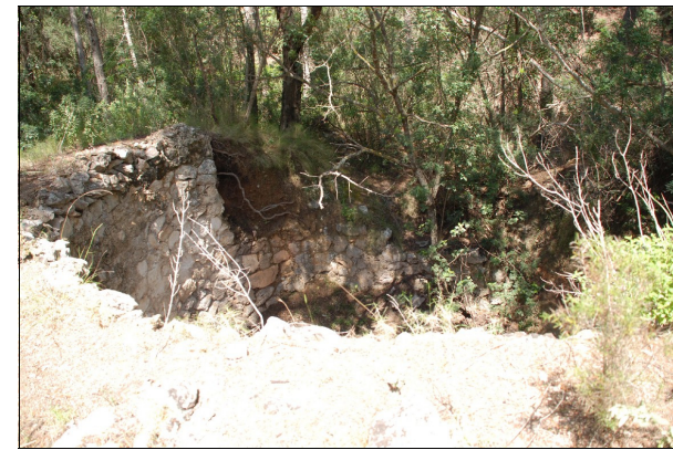
274-1: Vista general del horno de cal.
