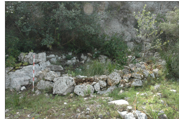
Descripción: Vista lateral de la estructura.
