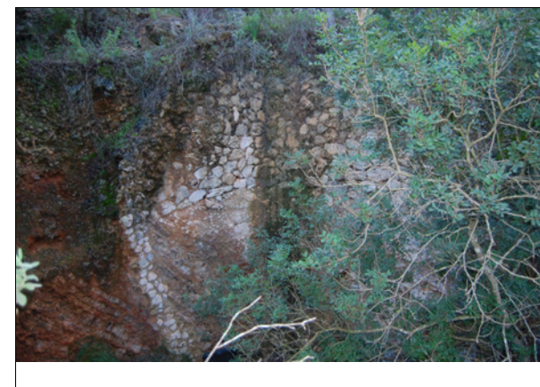
488.2: Detalle de la parte conservada del muro de la olla.
