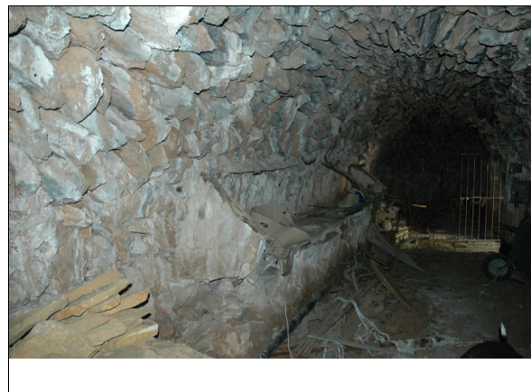
Descripción: Vista del ámbito 2 (comedero) y al fondo ámbito 1 pavimentado.
