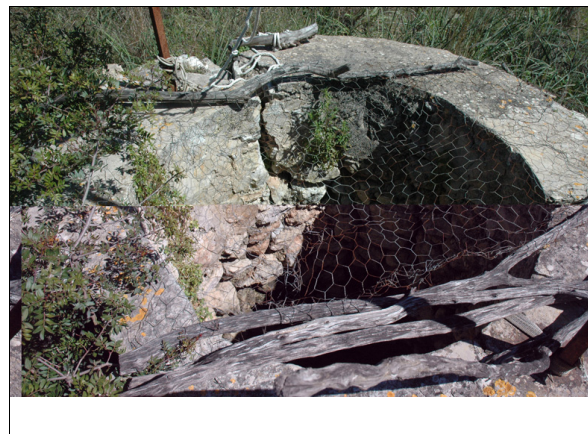
Descripción: Vista del interior del pozo
