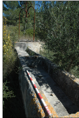
Descripción: Lecho de las pilas de abrevar-lavar.
