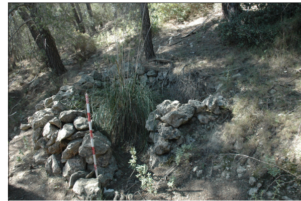
Descripción: Vista de la pared seca donde se asienta el conjunto.
