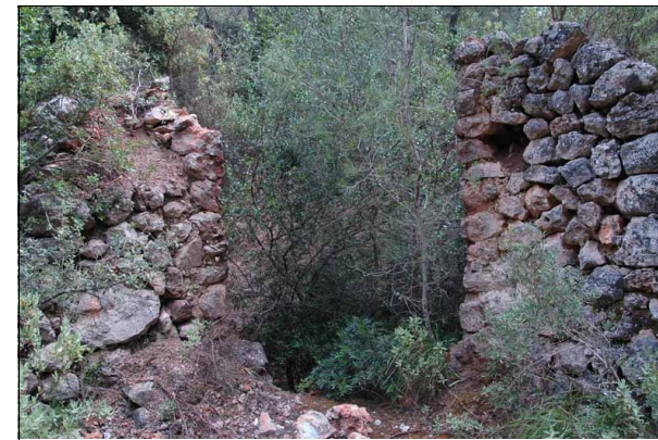
337-1: Boca del horno de cal.
