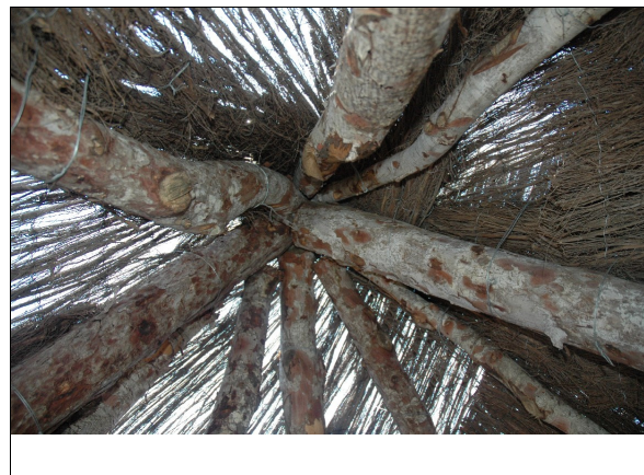
Descripción: 280-2: Detalle del embarrado de la cubierta, desde el interior.
