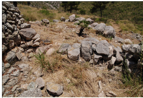
303-1: Paramento interno de la caseta de roter del interior de la naveta.
