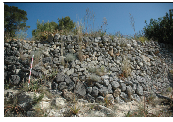
Descripción: Muro para salvar el desnivel del terreno.
