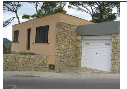
Descripción: Zona inferior destinada a portería y garaje de los propietarios. Los muros son de mampostería y la cubierta es plana. Los garajes están colocados de manera escalonada adaptándose a la curvatura de la calle. Se puede observar el pinar de la parte posterior.
