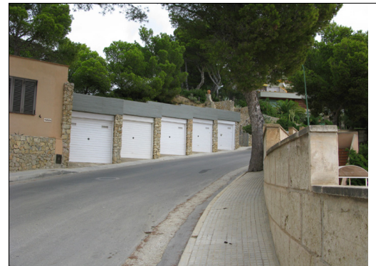
Descripción: Zona inferior destinada a portería y garaje de los propietarios. Los muros son de mampostería y la cubierta es plana. Los garajes están colocados de manera escalonada adaptándose a la curvatura de la calle. Se puede observar el pinar de la parte posterior.
