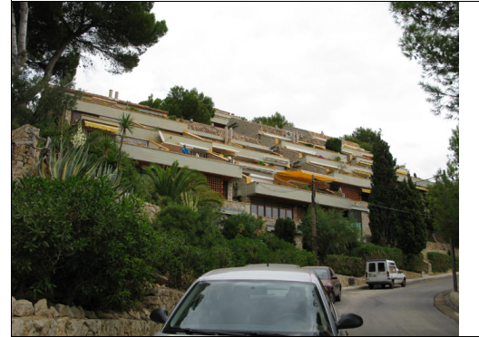
Descripción: Vista general del conjunto de viviendas. La zona frontal tiene unas jardineras realizadas con muro de piedra que dan intimidad a las plantas bajas. Los edificios se adaptan a la pendiente y a la curvatura de la calle.
