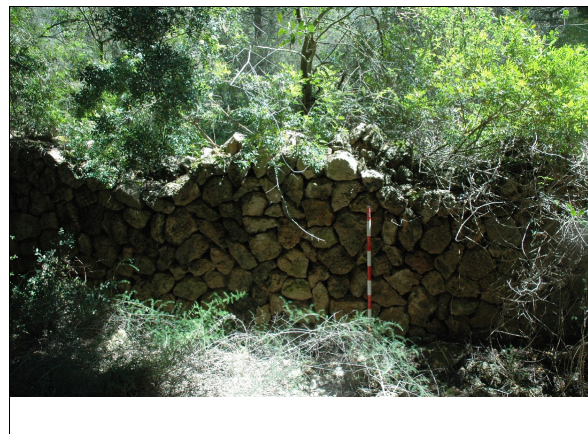
Descripción: Muro perimetral.
