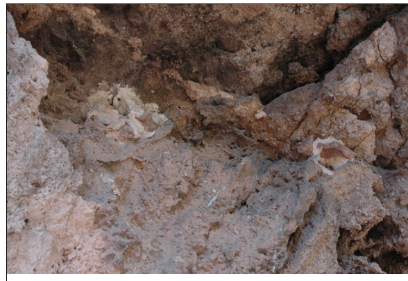
Descripción: Restos de vigas trabadas en la roca con mortero.
