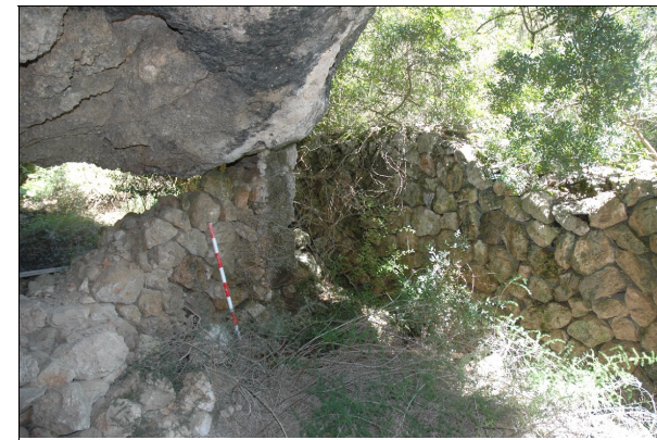
Muro de separación entre ámbito 1 y 2, acceso delimitado por columna que sustenta la roca y el muro perimetral.
