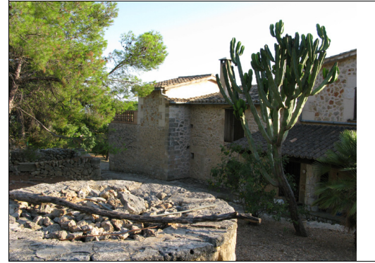
Descripción: Vistas de la fachada lateral formada por varios cuerpos de diferente altura y que corresponden a una terraza, un almacén y la cocina con porche. Las cubiertas son inclinadas, de una vertiente con teja árabe aunque con diferente orientación.
