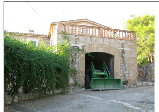
Descripción: Cuerpo adosado a la vivienda principal de una altura con una puerta de dos hojas formada por un arco escarzano que sirve de garaje. Está cubierta por una terraza, rodeada por una balaustrada de piedra.
