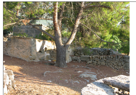
Descripción: Vista desde la parte posterior, se puede ver el porche situado en un extremo y el recinto abierto en el otro. Ambos muros son de mampostería, y se adaptan a la pendiente del terreno.
