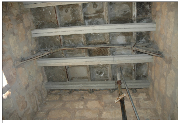
Descripción 350-1: Detalle del engigado interior.
