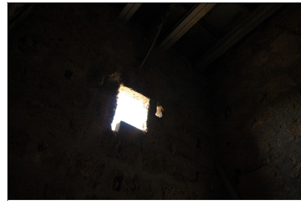
Descripción 350-1: Pequeña ventana en la pared Sur del segundo piso, actualmente derruido.
