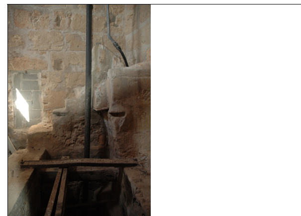
Descripción 350-1: Interior del molino, con pozo y escalera de acceso.
