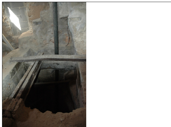
Descripción 350-1: Detalle del pozo del interior del molino.
