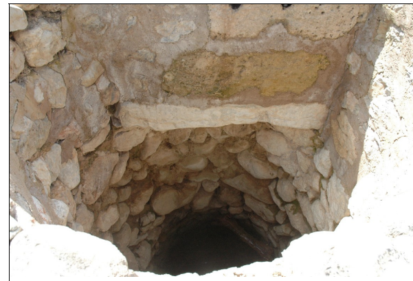
Descripción 285-1: Detalle del interior del pozo (clot paredado).
