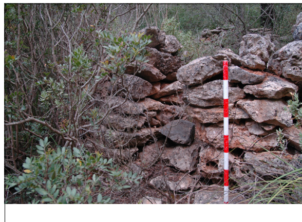
340-1: Detalle vano de ingreso a la barraca de carbonero.
