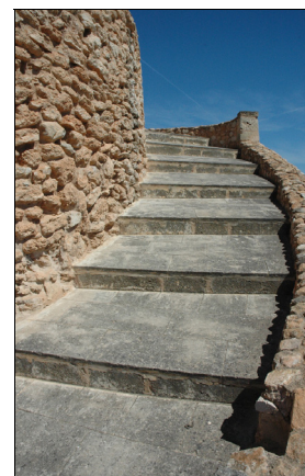
Descripción: Escalera de acceso a la cubierta del envelador.
