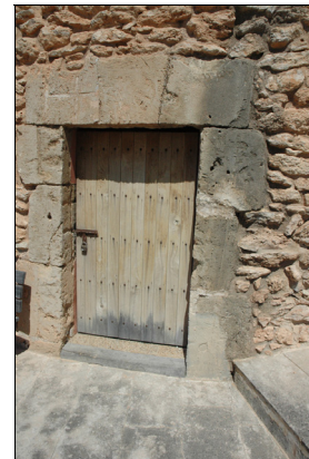
Descripción: Puerta de acceso al cintell o envelador
