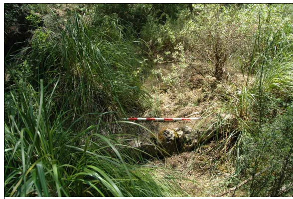
Descripción: 297-1: Detalle del rotllo y del pavimento de la sitja.
