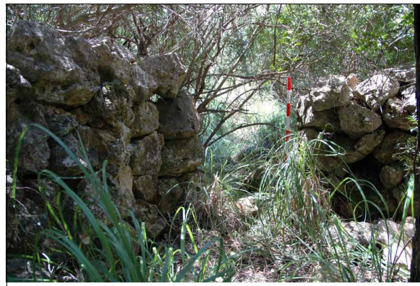
Descripción: 297-2: Detalle del vano de ingreso a la barraca.
