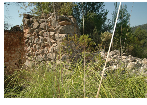
Descripción: Jambas de la puerta del horno.
