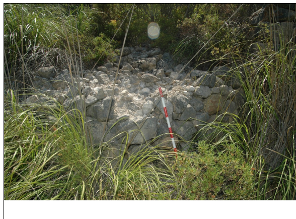
Descripción: Acumulación de piedras y muro en el muro de la puerta.
