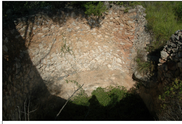
Descripción: Muro de la olla en la zona de la puerta.
