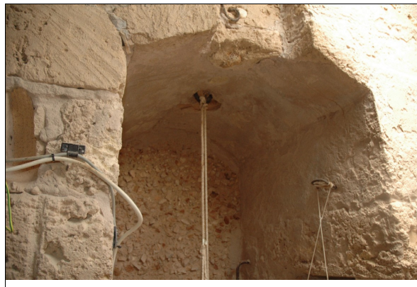
Descripción 348-1: Vano en el que se ubica el pozo del molino.
