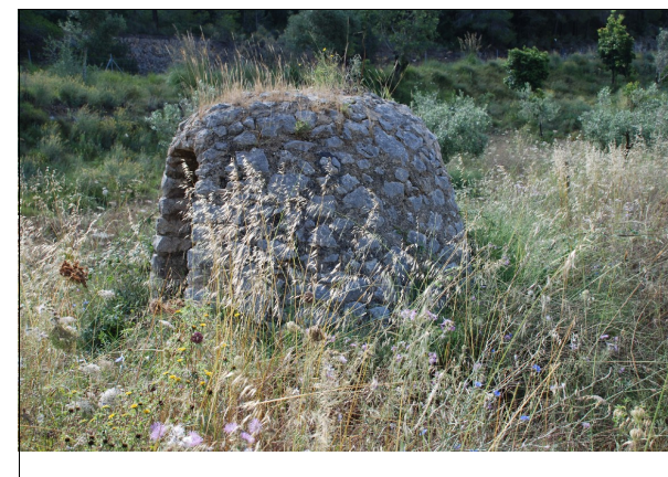
272-1: Vista lateral del pozo.
