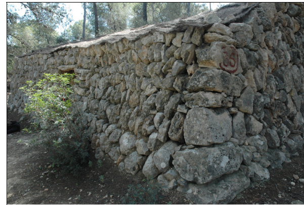
Descripción: Vista de las técnicas constructivas de las esquinas y el alzado del muro.
