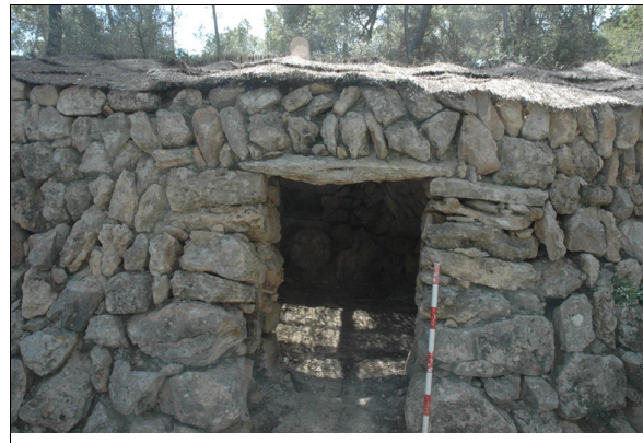
Descripción: Pared frontal y puerta de ingreso de la barraca.
