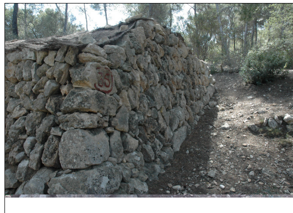
Descripción: Vista de las técnicas constructivas de las esquinas y el alzado del muro.
