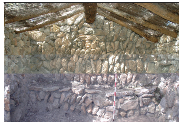
Descripción: Banco en el interior de la barraca y envigado de la cubierta.
