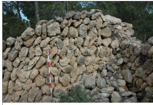
Descripción: Muro en mejor estado de conservación.
