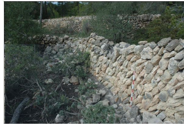
Descripción: Muros oeste y sur de la estructura, interior colmatado por derrumbes y vegetación
