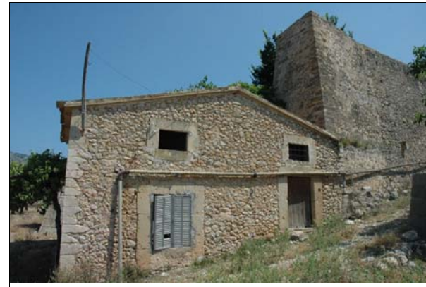
Descripción: 083-8: Caseta adosada a la torre del molino.
