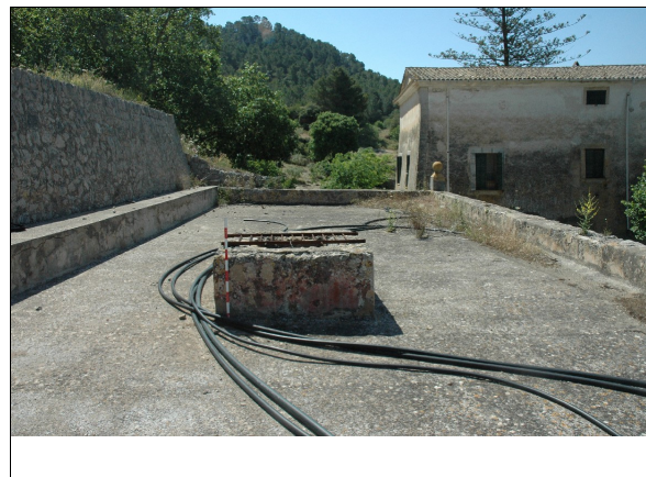
Descripción: Cubierta del Aljibe. 154.3
