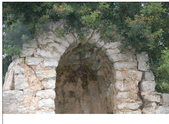
290-1: Detalle de la cubierta del pozo.
