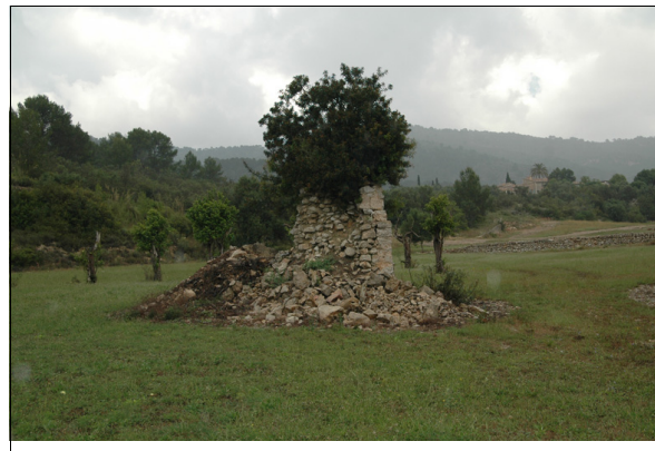
290-1: Vista lateral del pozo, con cintell derruido.
