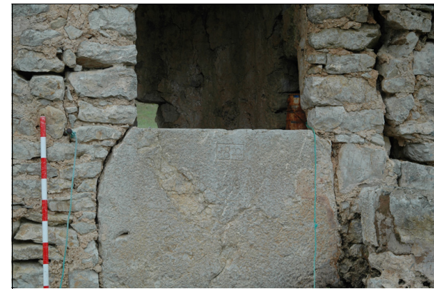
290-1: Vista general del Pou de Sa Vinya.
