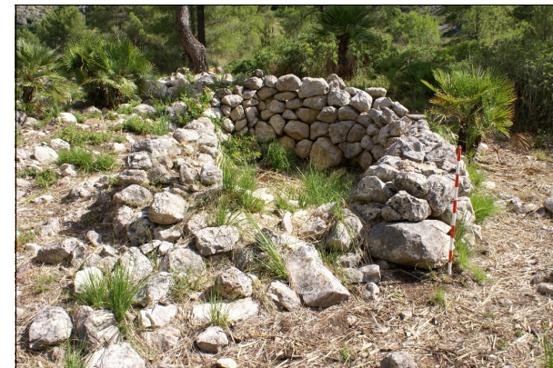
307-1: Caseta de carbonero. Vista general.
